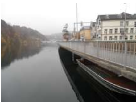
Bestand Rhein / Kraftwerk
